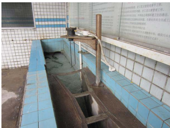
污水处理站排放槽
